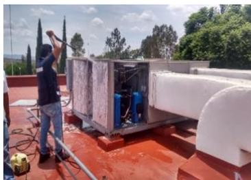
Figura 111. Mantenimiento de aires acondicionados
